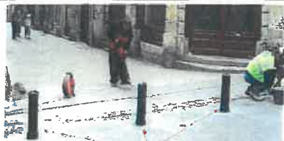
Bornes sécables Bornes sécables par un homme sur poussée
